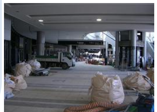
復旧が進む仙台空港ロビー
