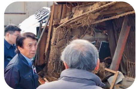
倒壊が激しい被災地の現場を視察。
